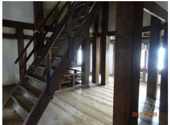
丸亀城天守閣の階段と柱
